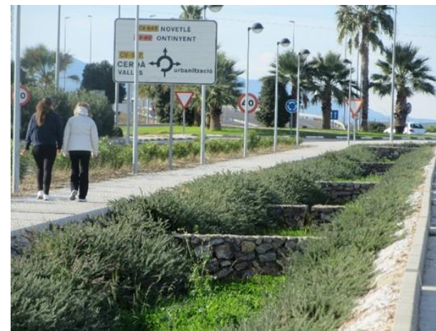
Cuneta vegetada con represas en Xàtiva (Valencia).
