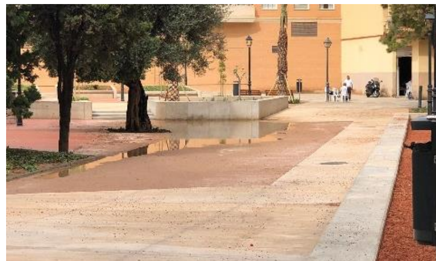
Imagen 31. Infiltración progresiva de la escorrentía tras finalizar el evento.
