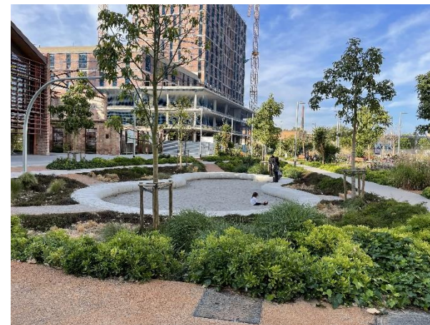
Balsa de infiltración en Moura, Barcelona.
