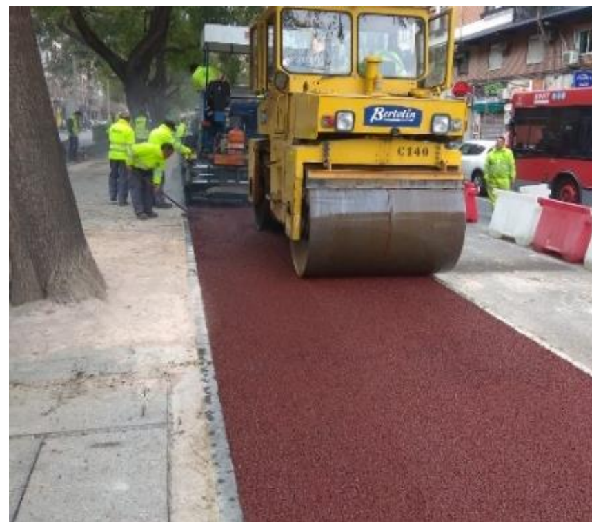
Imagen 34. Pavimentación del carril bici de la calle Manuel Candela.
