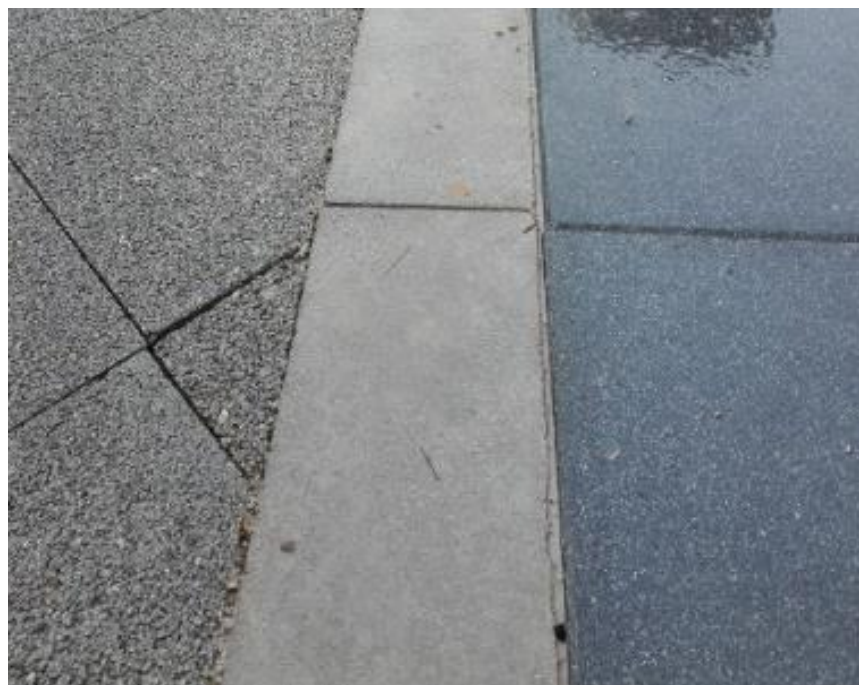
Imagen 32. Detalle del pavimento permeable en un día de lluvia en la plaza Lorenzo de la Flor. De izquierda a derecha: pavimento permeable, rigola de hormigón poroso y adoquín impermeable.
