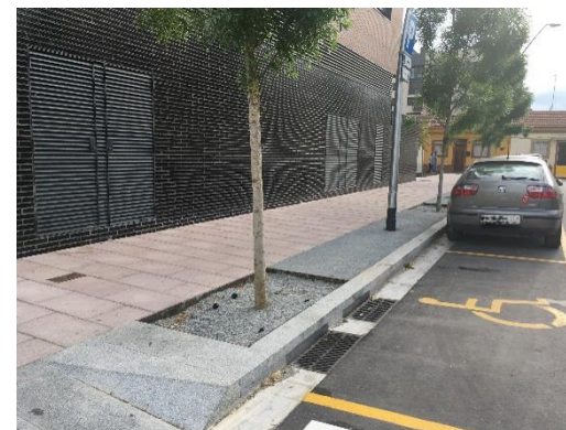
Alcorques estructurales en Bon Pastor, Barcelona.
