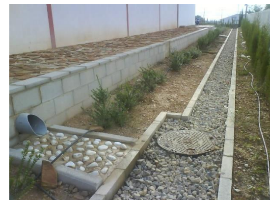
Drenes filtrantes en Crevillent (Alicante).
